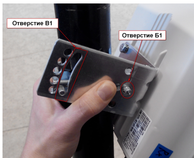
Рисунок 10 – Установка кронштейна на мачту
